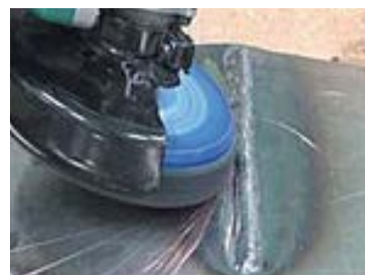
*odstraňovanie farebných defektov po zvaroch
